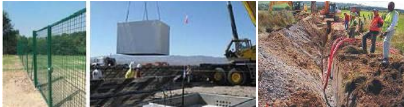
Illustration 85 : Exemple de chantier d'un parc photovoltaïque au sol
